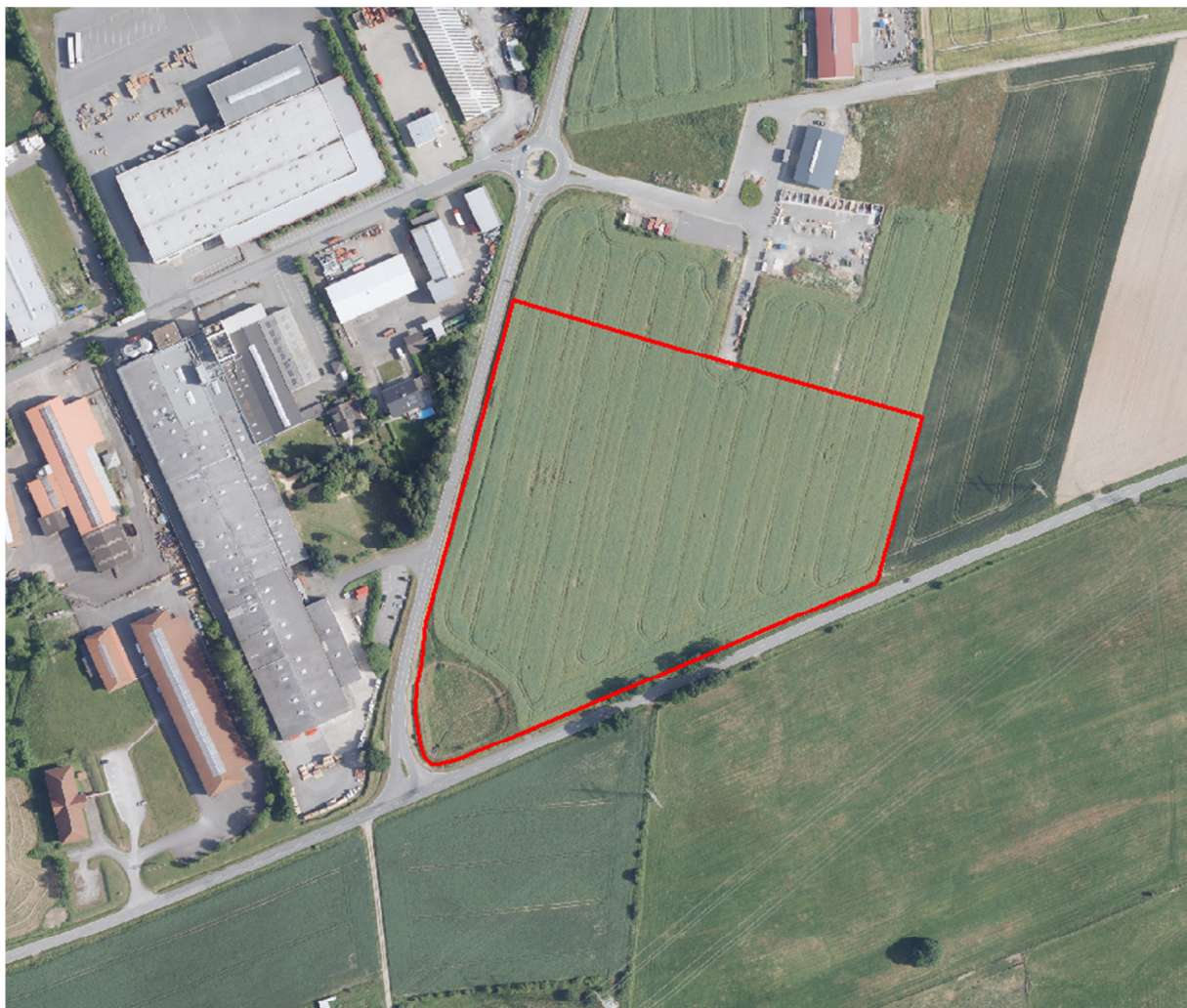
Abbildung 4: Luftbild mit Darstellung des Plangebiets (rot umrandet) (Luftbild: Land NRW (2019), Datenlizenz Deutschland – Namensnennung – Version 2.0, www.govdata.de/dl-de/by-2-0 )
